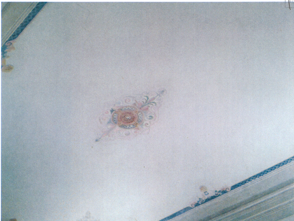
Foto 6 (vista interna piano primo)
