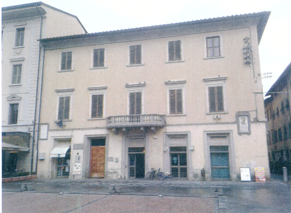
Foto 10 (Prospetto su Piazza Cavour)
