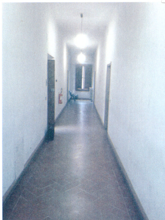
Foto 8 (vista interna piano secondo)
