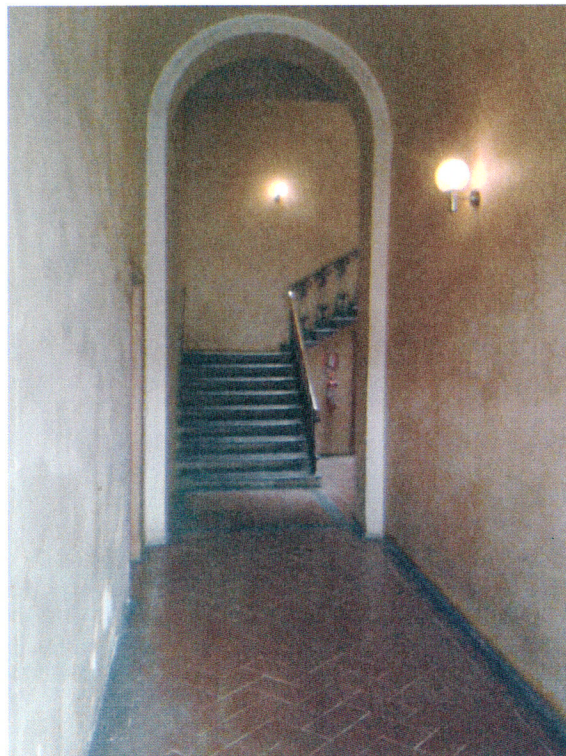
Foto 2 (Vista ingresso-vano scale, piano terra)
