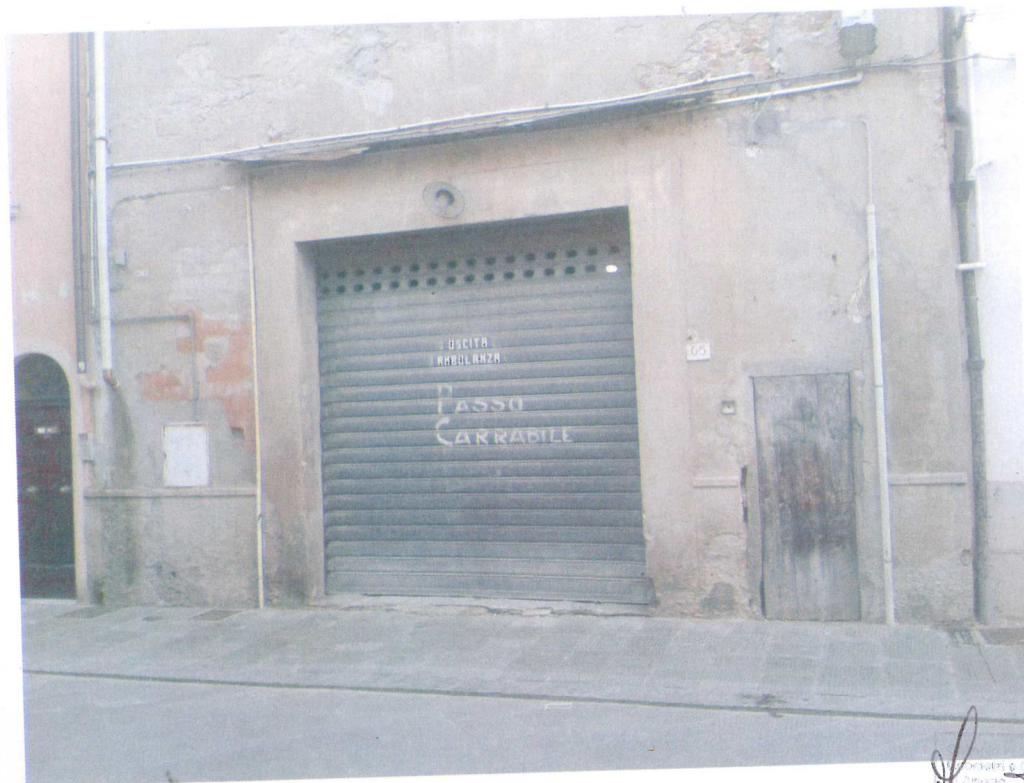
Foto 5 (vista esterna - ingresso)
